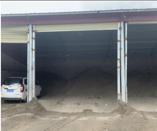
砂料堆场粉尘治理措施（三面围挡+雨棚）
