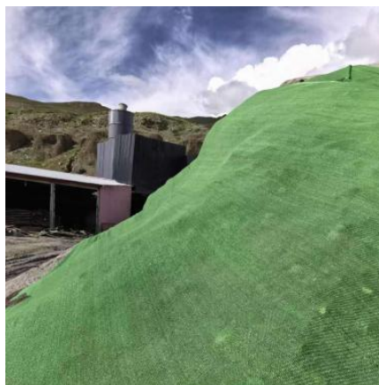
碎石堆场防尘网遮盖（整改后）
